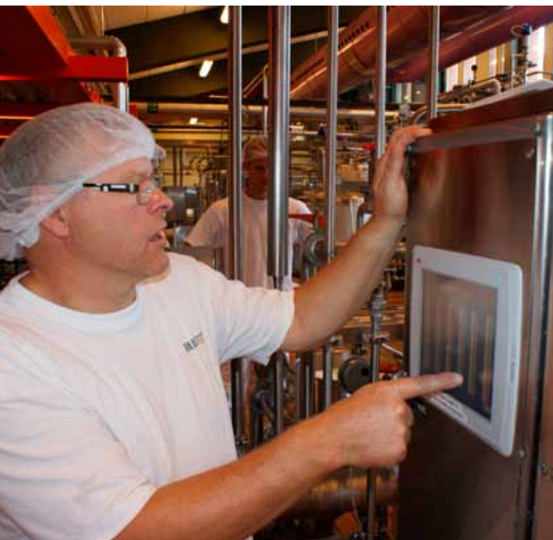
Der stilles i dag store krav til hygiejne inden for mejeribranchen, hvorfor CIP-anlæg (Cleaning In Place) har vundet frem. Her underviser mejerilærer Birger Holmås Christiansen i brug af træningsmejeriets CIP-anlæg (Kold College).
