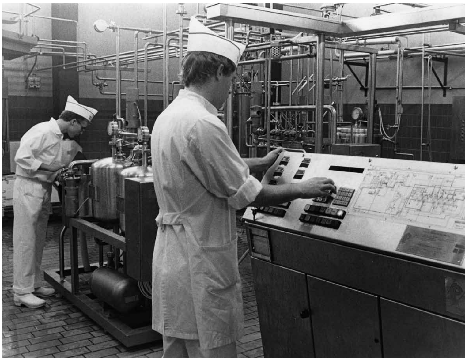
Arbejde ved styrepult til UHT-anlæg i 1980'erne. Processtyring og automatik vandt for alvor frem i mejeriindustrien fra 1970'erne og blev også en naturlig del af undervisningen på mejeriuddannelsen. Med mejeribranchens specialisering fik træningsmejeriet i stigende grad til opgave at give eleverne praktisk indsigt inden for alle de forskellige fremstillingsprocesser (Odense Stadsarkiv).
