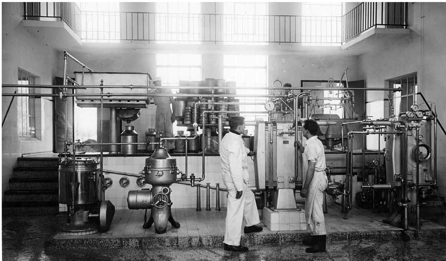
Skummesalen på det nye mejeri, som blev opført ved Dalum Landbrugs- og Mælkeriskole i 1931. Opførelsen af skolens funktionalistiske mejeri var en omfattende affære, der også indbefattede byggeriet af en lærer- og mejeristyrerbolig i den tidligere laboratoriebygning ved Odensevej (Odense Stadsarkiv).
